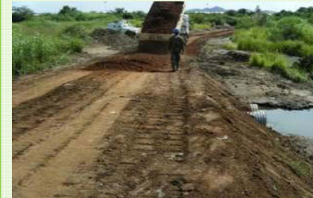
避難民保護区域の警備用 外周道整備 2014.6～2014.8
