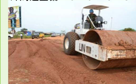
市内幹線道路の補修 2014.7～
