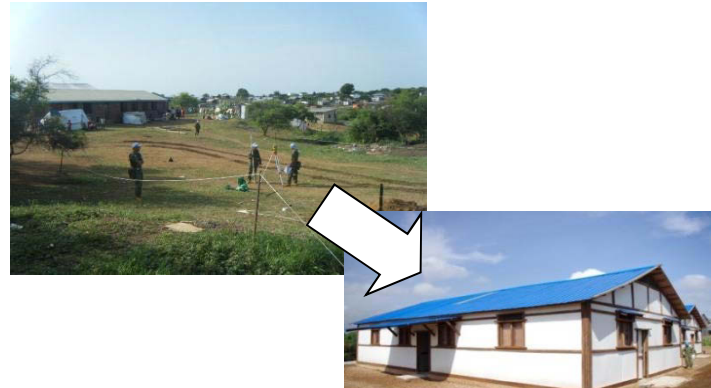
UNHCR帰還民一時収容施設の敷地造成
