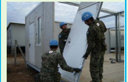
他国部隊用コンテナの 設置 2014.8～
