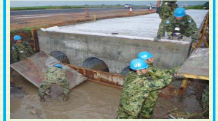
ジュバ空港の誘導路排水整備 2014.7～2014.10
