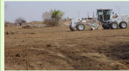
避難民保護区域の敷地造成 2014.1～2014.5
