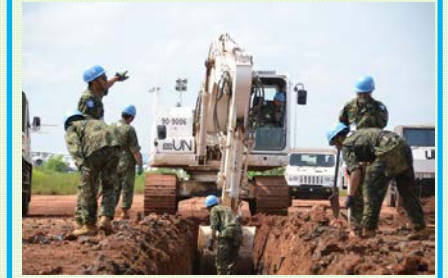
国営放送局の側溝整備 (同局ではJICAがODA事業で人 材育成支援を実施) 2015.2
