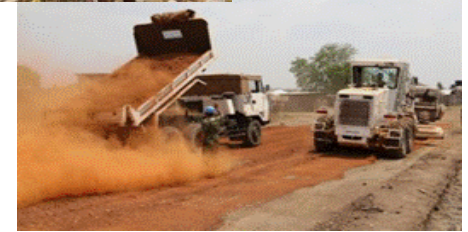
活動地域における地元住民との清掃作業(左)と、道路整備作業の様子(右)。
