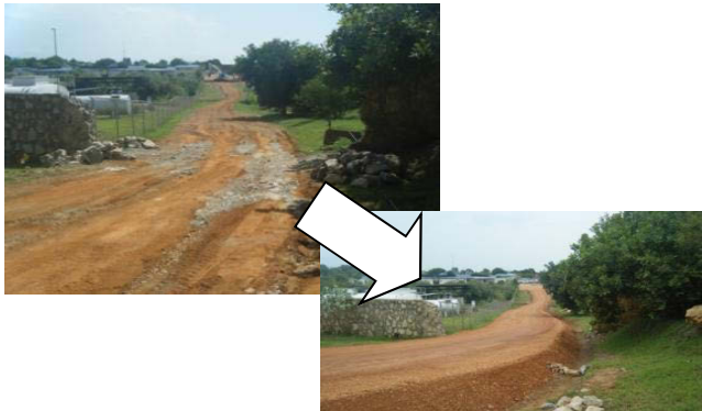
WFP敷地内道路等整備作業
