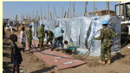
避難民用衛生設備(トイレ)の設置
