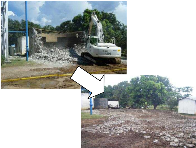
作業前(左)と、作業後の様子(右)。
